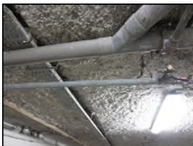
Photo N° 584 ECH-N°1 FLOCAGE -- PARKING Plafonds BLANC COTONNEUX
